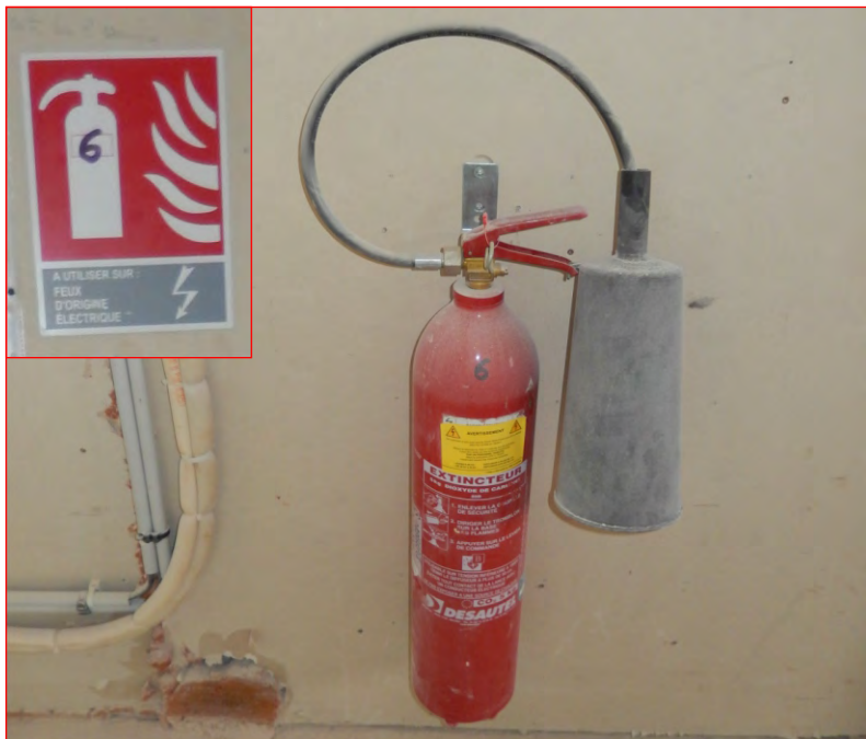
Alimentation en électricité de la plate-forme technique (1 extincteur) Extincteur CO 2 5 kg Classe B
