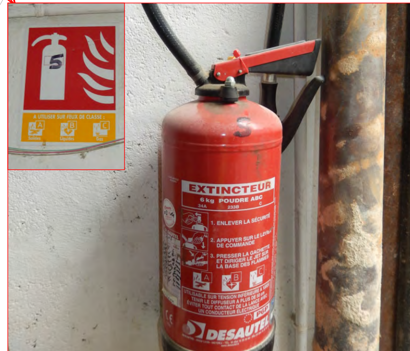
Aire de ravitaillement (1 extincteur), installation mobile de concassage-criblage (2 extincteurs), chargeuse (1 extincteur) Extincteur Poudre 6 kg Classes A, B et C
